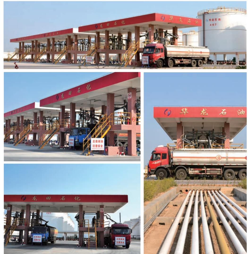
二号库区装车台采用专罐专线设计，可同时满足所有储罐同时装车的需要，装车台配备先进的自动化定量装车系统。
