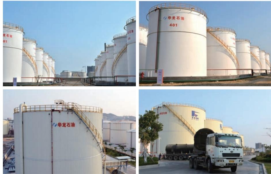
一号库区建有 15 个储罐，总库容 5 万立方米。二号库区建有 42 个储罐，配备有 3 个罐组并配备装车、装船泵房、制冷车间，总库容近 10 万立方米。
